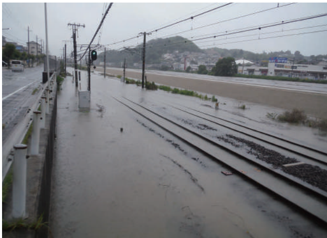
▲令和5年6月の線状降水帯の影響で線路が冠水
