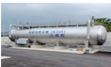
耐震性貯水槽 (給食センター敷地内)
