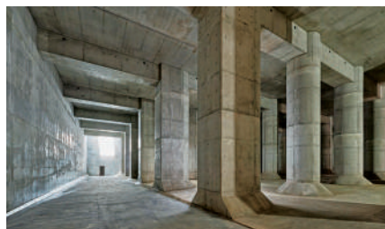
惣持寺地区 調整池
