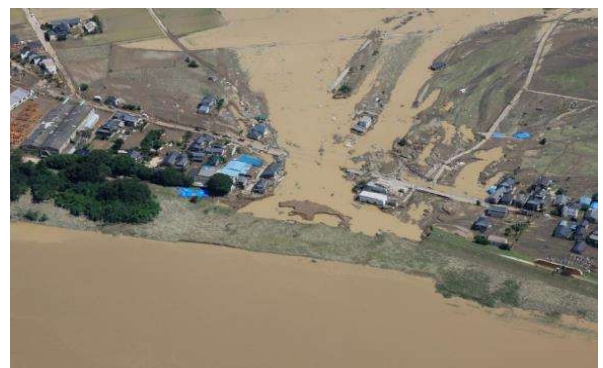
堤防決壊による家屋の流失(鬼怒川)
