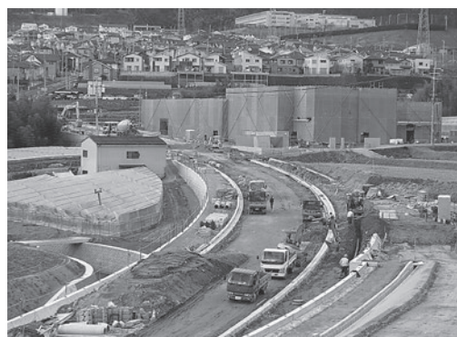
▶ 工事の様子（建築中の建物は新給食センター）
