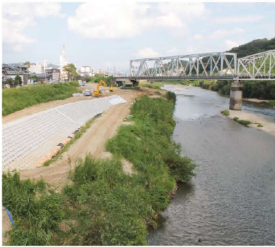
現在工事が行われている 大正橋付近の様子 (R1.10月)
