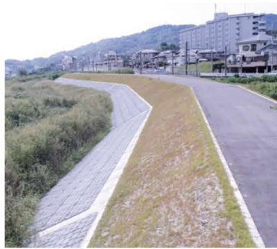
平成30年度に築堤工事が 行われた神前橋付近
