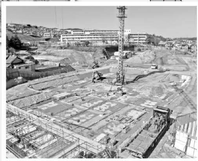
校舎棟工事現場の様子▲
