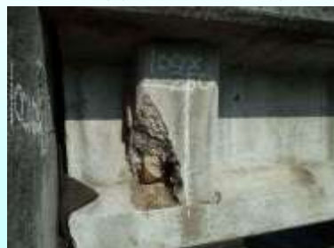
上部工の損傷（剥離・鉄筋露出）
