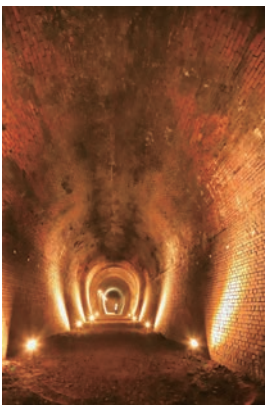
▲亀の瀬トンネル
