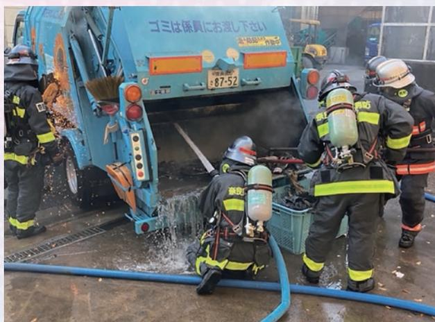
今回の火災原因は、穴の開けられていないスプレー缶のガス等がごみ収集車の積載部に充満し、そこに鉄類を積み込む際に起こる火花によって着火したと思われます。
