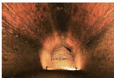
亀の瀬トンネル
