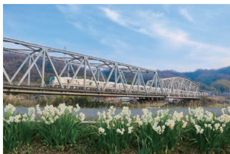
地すべりのために架橋された 第三大和川橋梁
