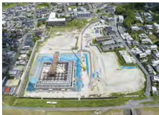
▲工事が進む惣持寺地区（令和5年7月末日時点）
