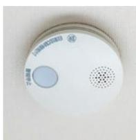
設置場所は、寝室、階段です。また、任意設置ですが台所や居室への取付けも推奨します。種類は煙式と熱式があり、寝室、階段には煙式のもので、検定合格証票マークの貼られているものを購入しましょう。交換時期としては10年を目安に交換をおすすめします。
