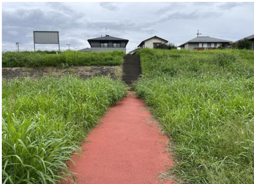
⑦往路: 階段(往路のみ階段を上る。階段は徒歩。)
