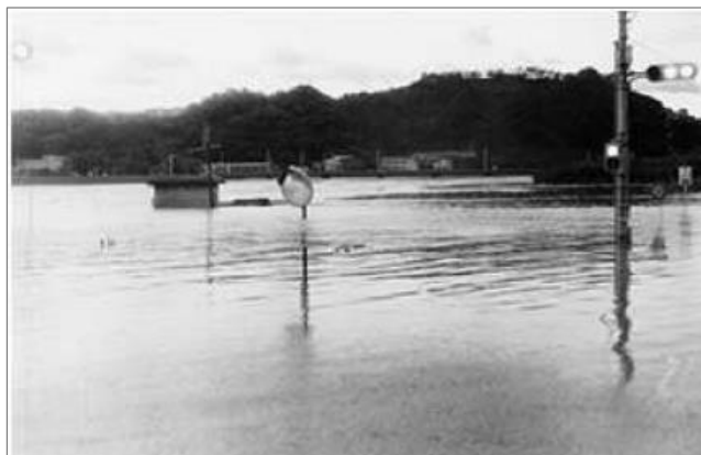
図 昭和57年(1982年)の大水害による被害状況
