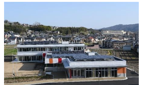
西部保育園（建物のZEB化）
